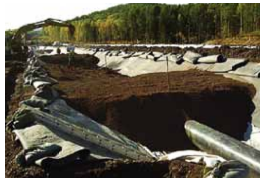
Засыпка спецтраншеи ПГС в зонах активных тектонических разломов
