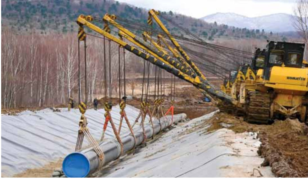
Прокладка газопровода в зонах активных тектонических разломов
