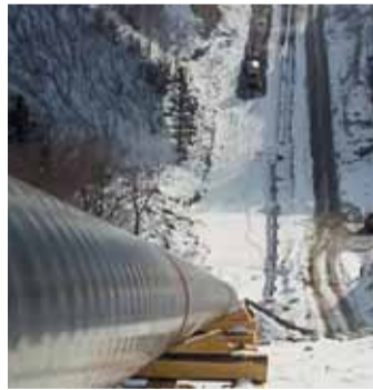
Прохождение газопровода по сопкам
