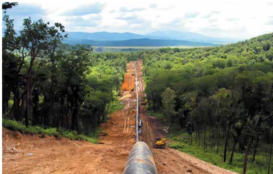
Прокладка трубопровода в условиях горной местности
