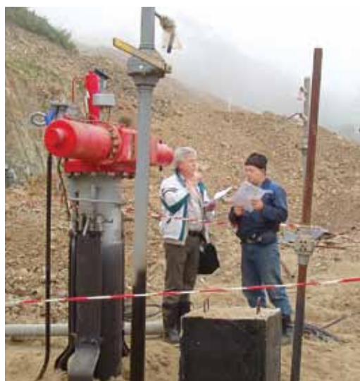
Мелехов Ю.А. на площадке охранного крана ГРС-1 «Владивосток» со сварщиком подрядной организации
