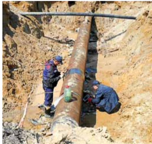
Выполнение ультразвукового контроля по объекту «Сахалин — Хабаровск — Владивосток» пересечение № 8. Спиридонов М. Г., Кошкин А. М.
