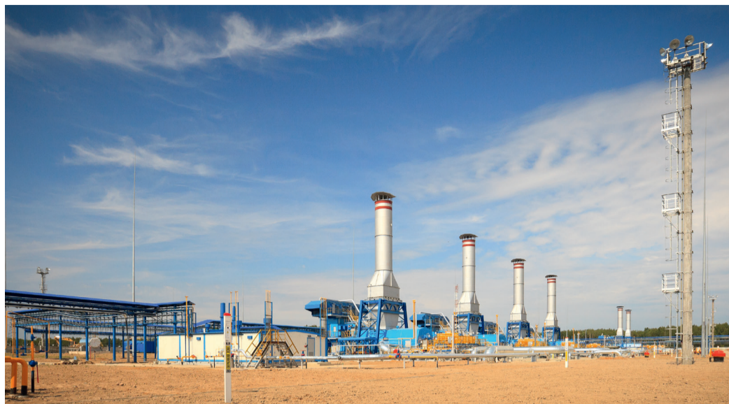
Компрессорная станция Ивановская
