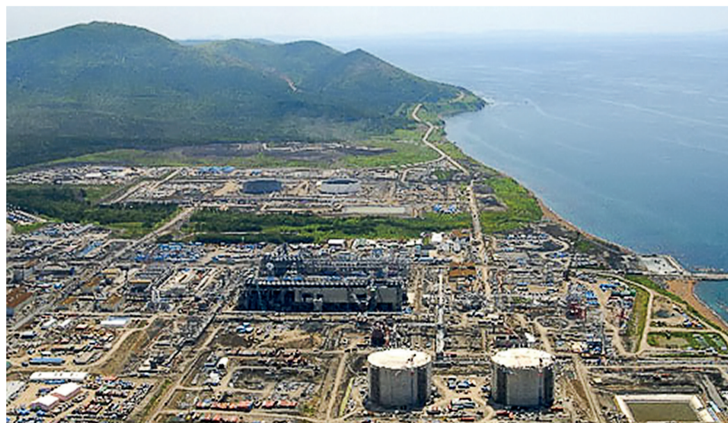
Строительство завода по производству СПГ
