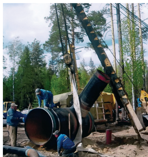
Монтаж тройника на участке газопровода
