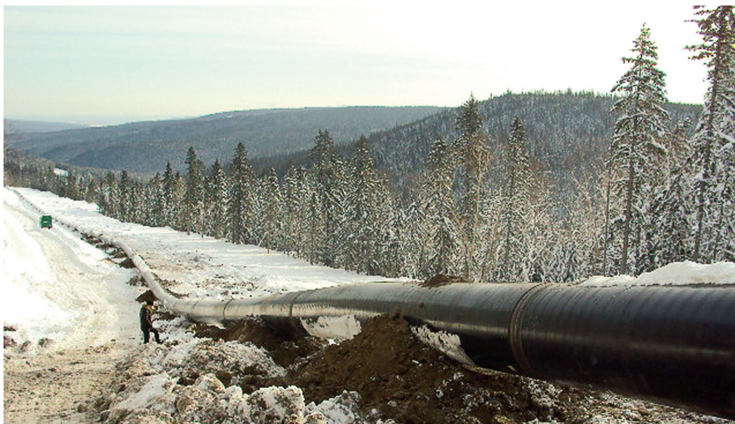
Прохождение газопровода по сопкам
