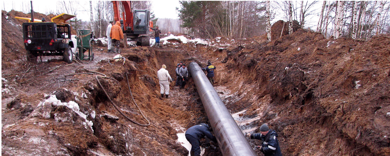
Проведение диагностических работ на нефтепроводе
