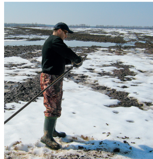
К.М. Симонян. Бурение ручным буром. Трасса газопровода Починки - Грязовец
