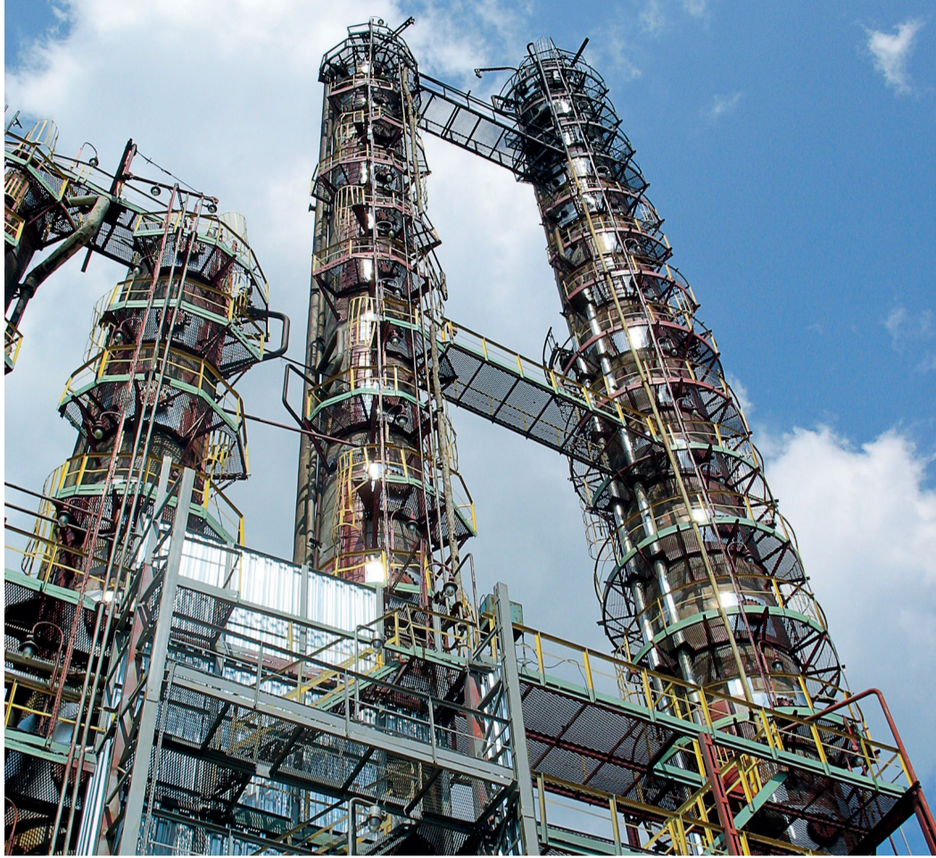
Замена колонны 1-К-1 на установке ГФУ
