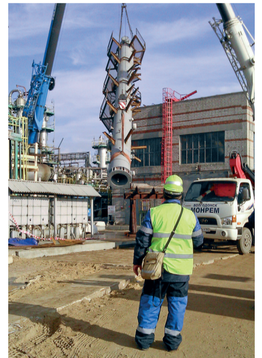
Монтаж новой колонны K-102 Установки гидроочистки дизтоплива. Авторский надзор.
